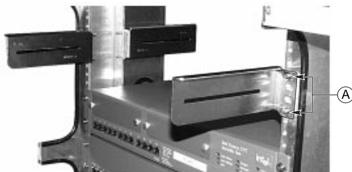
Рисунок 14. Скоба с пометкой FR/RL, прикрепленная к задней левой стороне стойки
